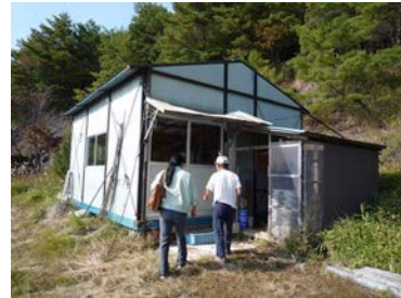
写真③ 作業小屋
