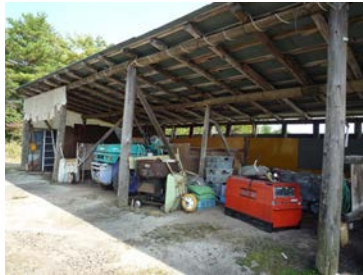
写真① 堆肥舎
